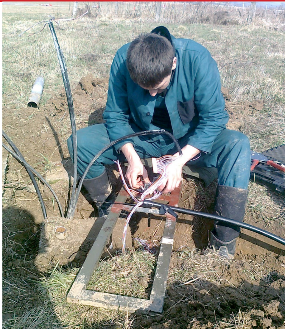
Oprava poškodeného kábla zamestnancom ZaSKIS
