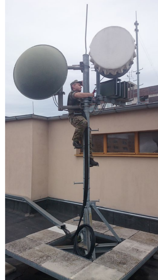
Montáž kabeľáže na zariadeniach rádioreleovej siete
